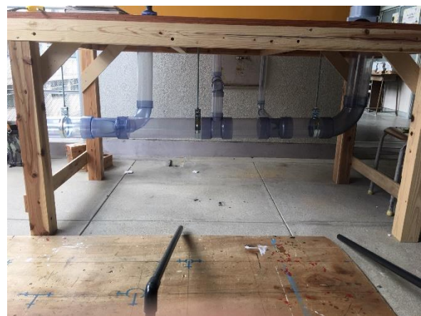
写真11 完成写真（排水・通気管）
