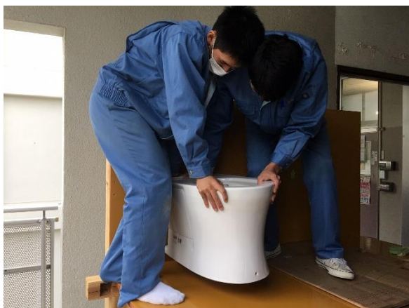
写真14 衛生器具の取り付け (1)
