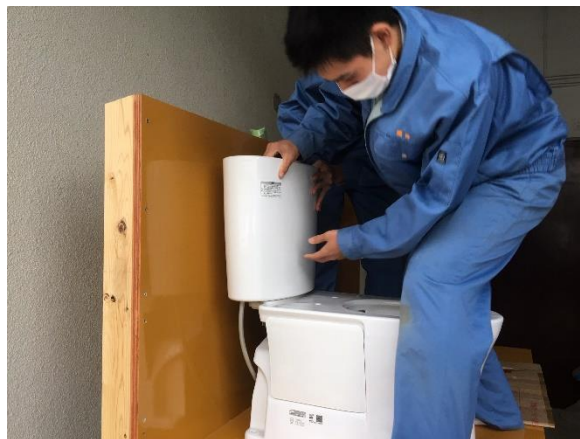
写真15 衛生器具の取り付け (2)
